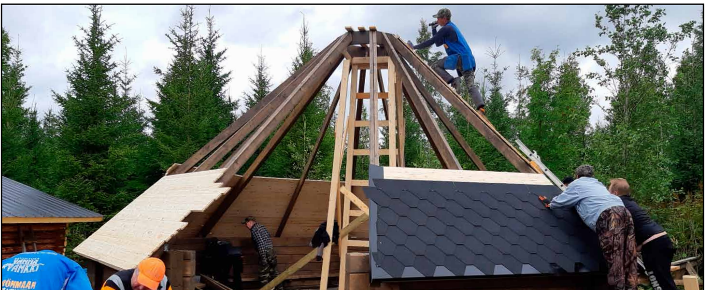
Katto pinnoitetaan palahuovalla.
