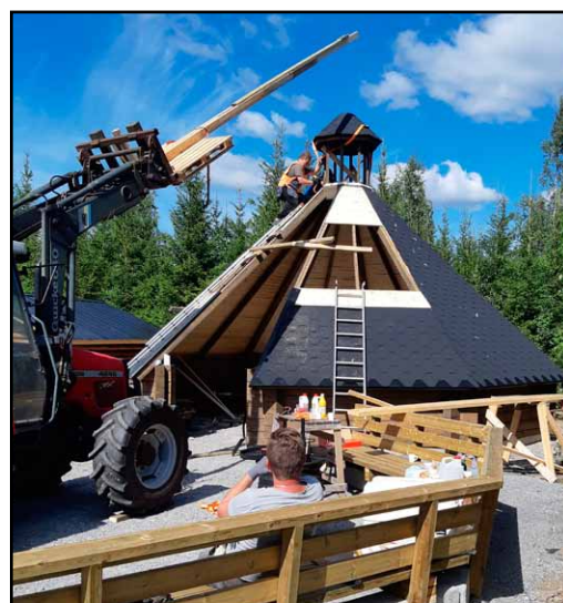
Talkootyötä riittää ja sää suosii. Kattorakennelma nostetaan huipulle kurottajalla.
