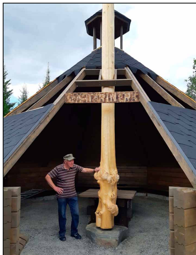
Viimeksi kiinnitettiin Ahtin tekemä nimikyltti. Kota on valmis! Tuloksena on uusi, esteetön virkistyskohde, jonka mielenkiintoisia yksityiskohtia pääsevät kaikki tutkiskelemaan ja viihtymään luonnossa.
