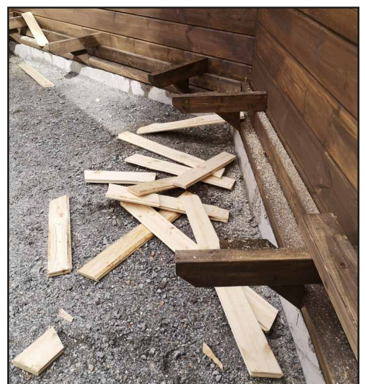
Hirsikehä nousee ja saa samalla suojauksen. Sisälle asennetaan samalla tukipuut penkkejä varten.
