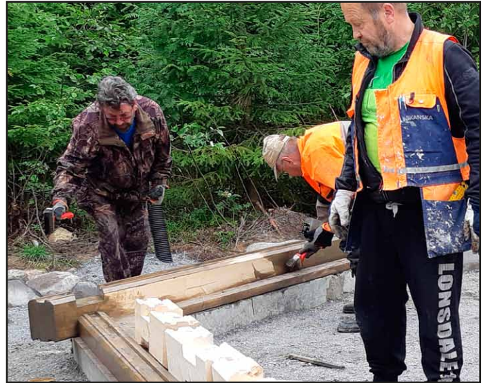
Seinähirsien sovittaminen alkaa.
