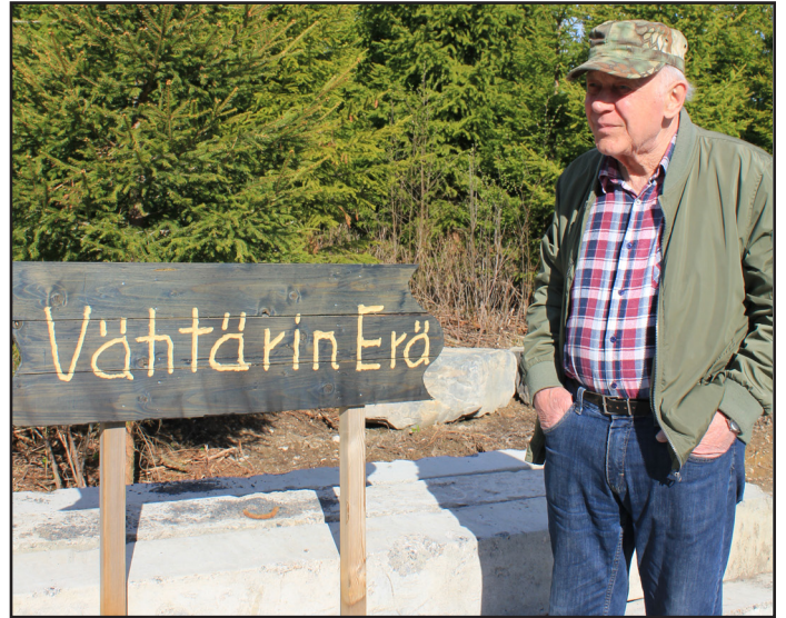
Vähtärin Erän puheenjohtaja Ahti Kuoppa-aho on tehnyt työmaalle yhdistyksen nimikyltin.
