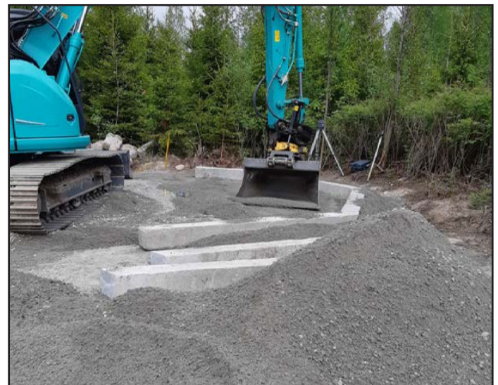
Perustuksen kiviä asetetaan paikoilleen.
