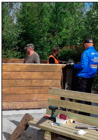
Hirsikehä nousee ja saa samalla suojauksen. Sisälle asennetaan samalla tukipuut penkkejä varten.
