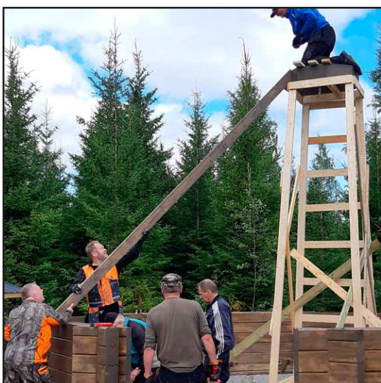
Katon runkorakenteet nousevat paikoilleen.
