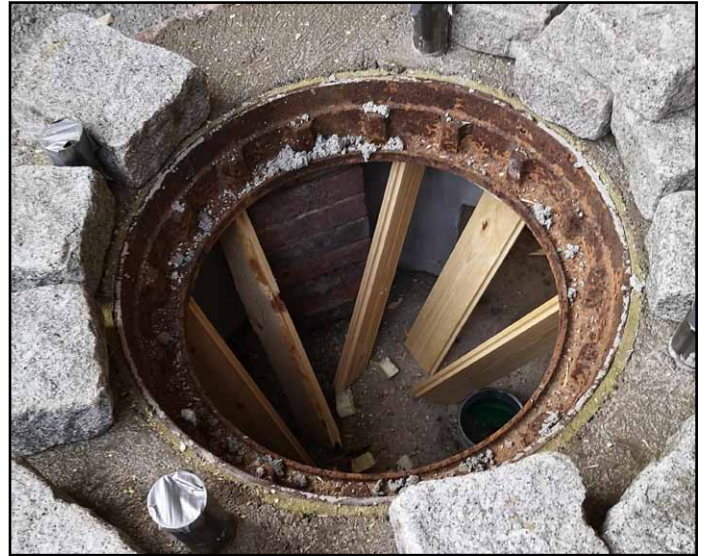
Puolikodan sisälle muurattiin tulisija.
