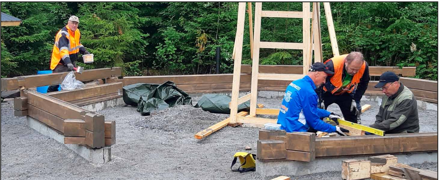
Alimmat hirsikerrat on asennettu.
