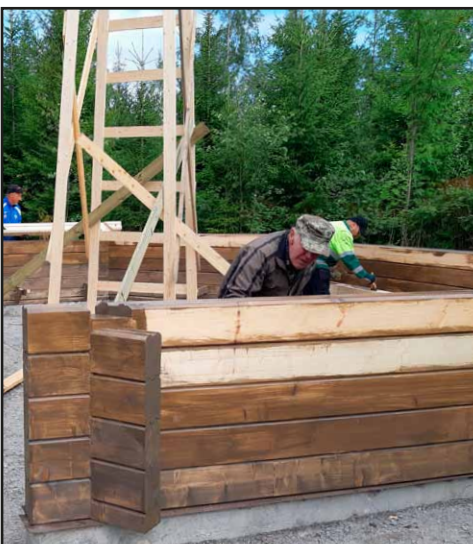
Hirsikehä nousee ja saa samalla suojauksen. Sisälle asennetaan samalla tukipuut penkkejä varten.
