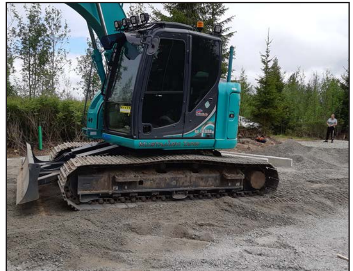
Pintamaat on poistettu, kuitukangas asennettu, lisätty mursketta ja tiivistetty pohja.
